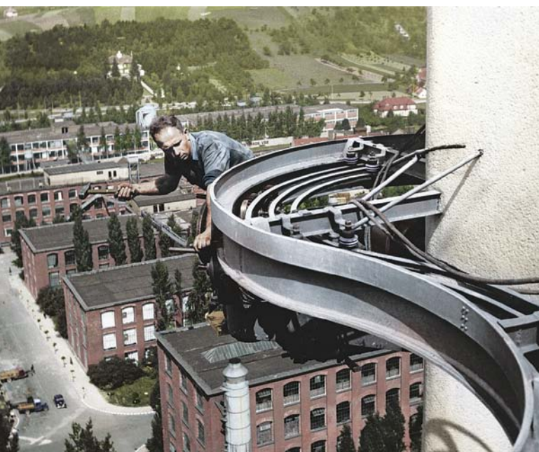
Výstavba 21. správní budovy/Construction of No. 21 Administration Building
