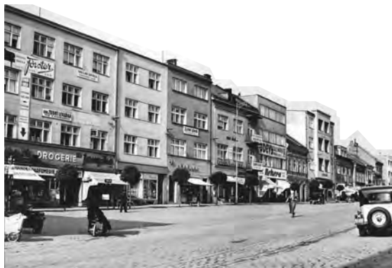
Novostavby severní fronty zlínského náměstí
